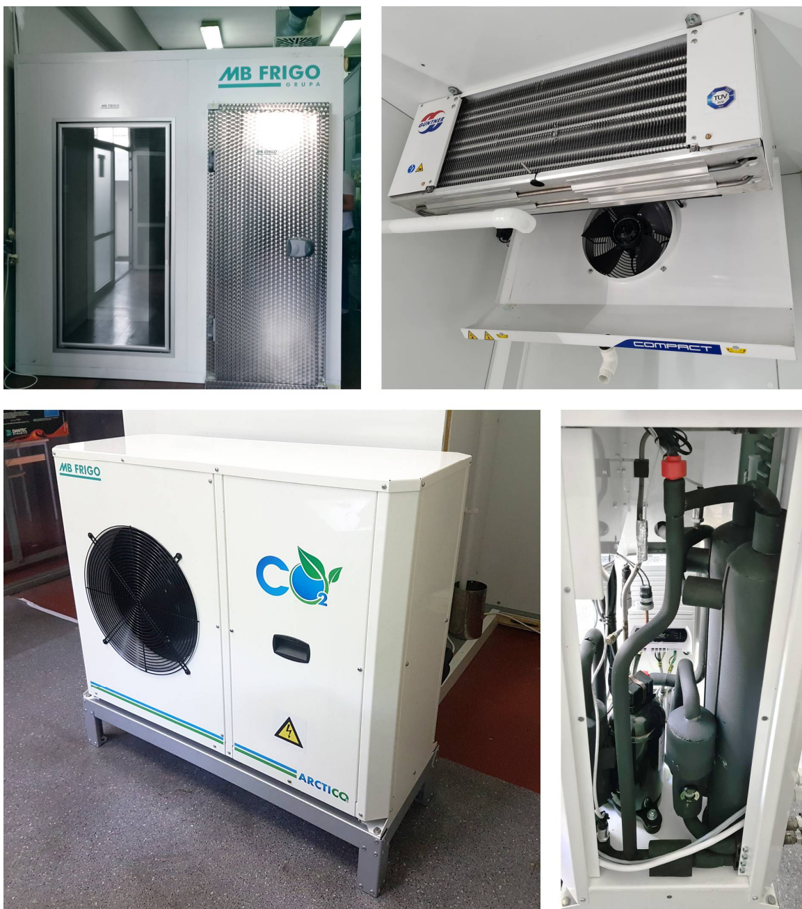
Slika 4.1 Rashladna komora (gore lijevo), isparivač unutar komore (gore desno), vanjska jedinica (dolje lijevo) i njeni osnovni dijelovi (dolje desno)
